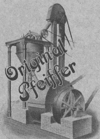
Broyeur-Séparateur Brevet Pfeiffer.
