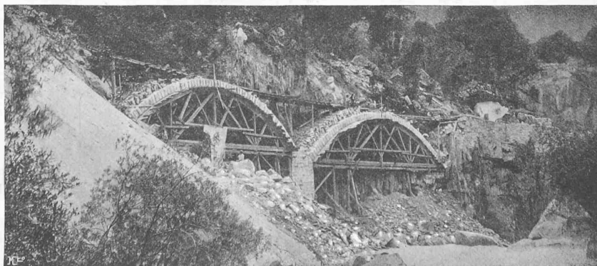
Fig. 4. — Pont au km. 6.850.
