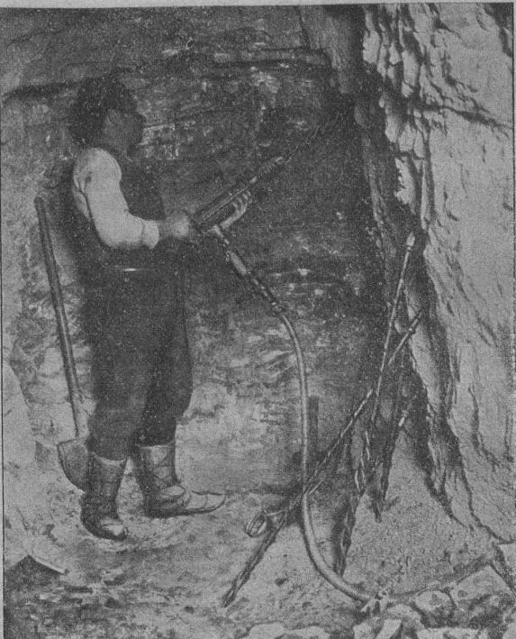
Marteaux perforateurs à air comprimé.
