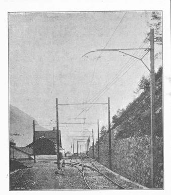
Fig. 29. - Suspension du fil de contact.
