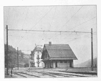
Fig. 28. - Suspension du fil de contact.
