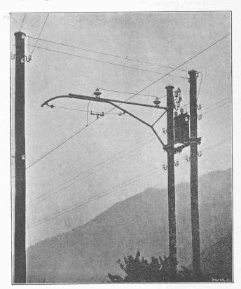
Fig. 31. - Transformateur pour l'éclairage des stations.
