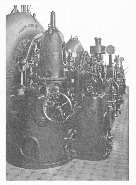
Fig. 9. — Turbines de 3200/3850 HP. de l'usine de la Kander, à Spiez. — Vue prise du côté du régulateur.
