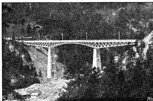
PONT SUR LA GRYONNE LIGNE BEX-GRYON-VILLARS
