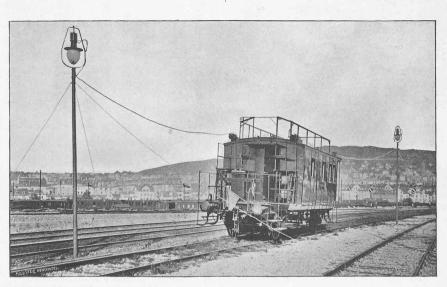
Fig. 8. - Eclairage d'un tronçon de la voie au moyen de la voiture.
