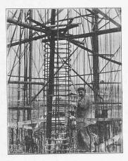
Fig. 10. - Ferraillage d'une colonne frettée.
