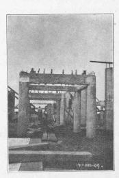
Fig. 4. — Colonnes accouplées supportant les trémies.
