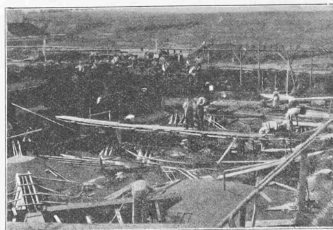
Fig. 1. — Fouille générale en bon terrain, profondeur 1 à 2 m. On remarque la première semelle armée qui porte 450 à 500 tonnes et les répartit à raison de 2 kg./cm 2 .
