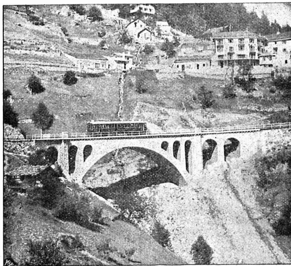
Viaduc des Torrents à Finhaut, Ch. de fer Martigny-Châtelard.
