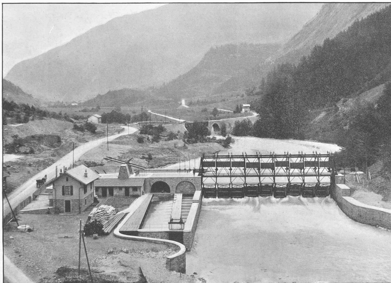
Fig. 5. — Ensemble de la prise d'eau, vue de l'aval.
