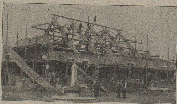
**Poutres composées** à remplissage parabolique, pour portées libres jusqu'à 8 m. et suchages considérables.
