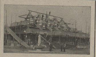
Poutres composées à remplissage parabolique, pour portées libres jusqu'à 8 m. et ucharges considérables
