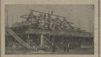
Poutres composées à remplissage parabolique, pour portées libres jusqu'à 8 m. et
