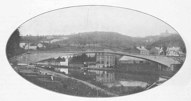
Fig. 10. — Pont sur la Sambre, à Namur (Belgique). Portée : 52 m. ; épaisseur à la clef : 0,25 m. Exécuté par la Société de fondations sur pylones Compressol.
