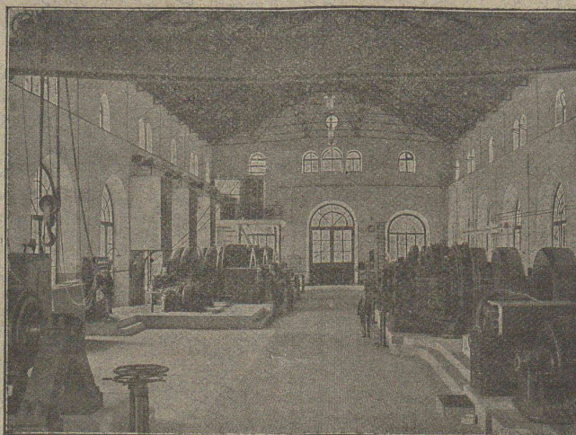
Usine d'électrochimie de Martigny. — Local des turbines.
