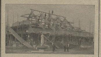
Poutres composées à remplissage parabolique, pour portées libres jusqu'à 8 m. et sucharges considérables
