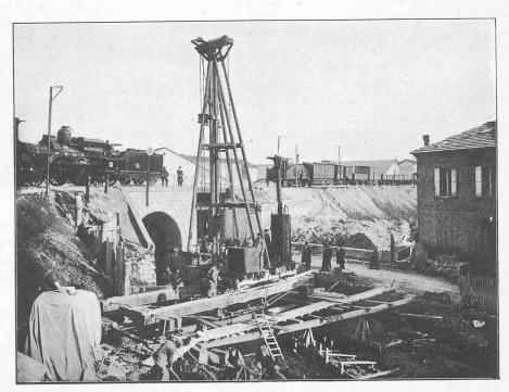
Fig. 3. — Fondation de la pile et des culées du viaduc de St-Roch.
