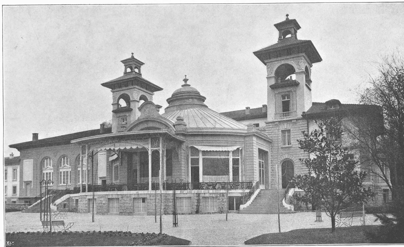
LE CASINO DE LAUSANNE-OUCHY
