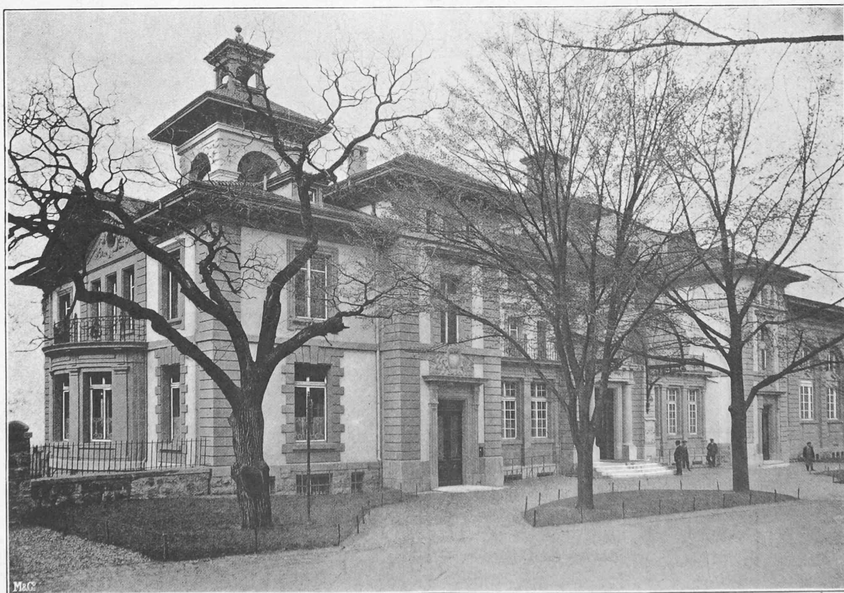
Casino de Lausanne-Ouchy. — Façade nord. — Architecte : M. H. Meyer, à Lausanne.
