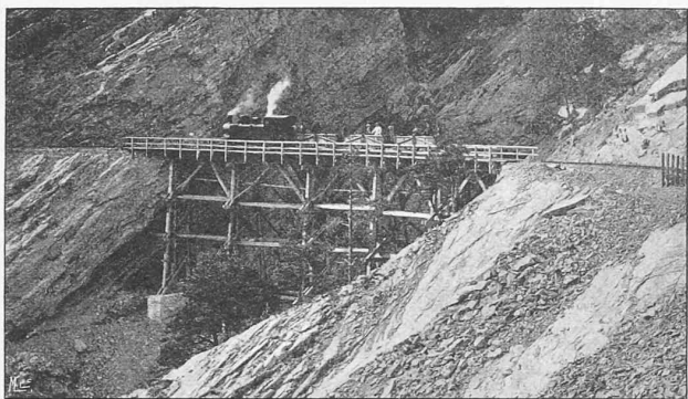
Fig. 27. — Rampe sud. — Pont de service du Luegelkinn.
