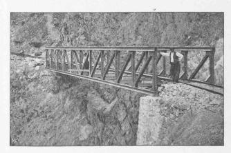
Fig. 28. — Rampe sud. Pont de service de Mitthalgraben (portée 22 m.).
