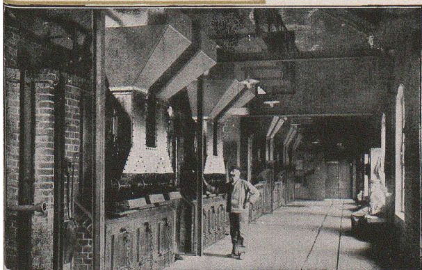
Installation d'alimentation automatique de générateurs
