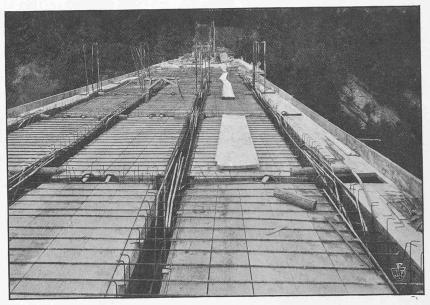
Fig. 9. - Armature de la chaussée.
