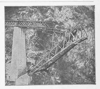
Fig. 3. - Montage d'une partie de l'arc.
