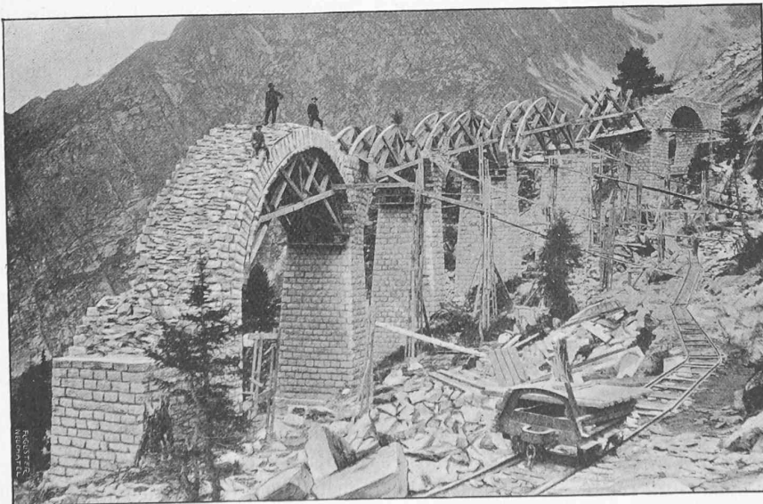
Fig. 13. — Le viaduc du Montenvers en construction.
