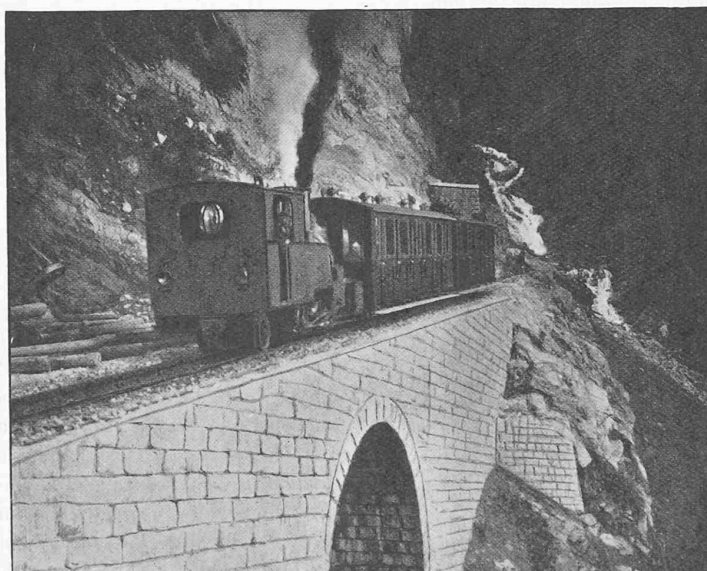
Fig. 3. — Tête aval du tunnel du Greppon.
