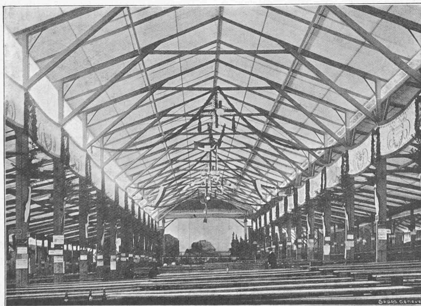
Fig. 2. — Vue intérieure de la cantine.
