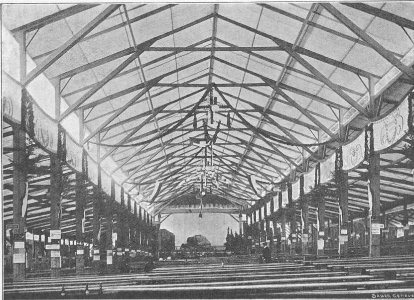
Fig. 2. — Vue intérieure de la cantine.
