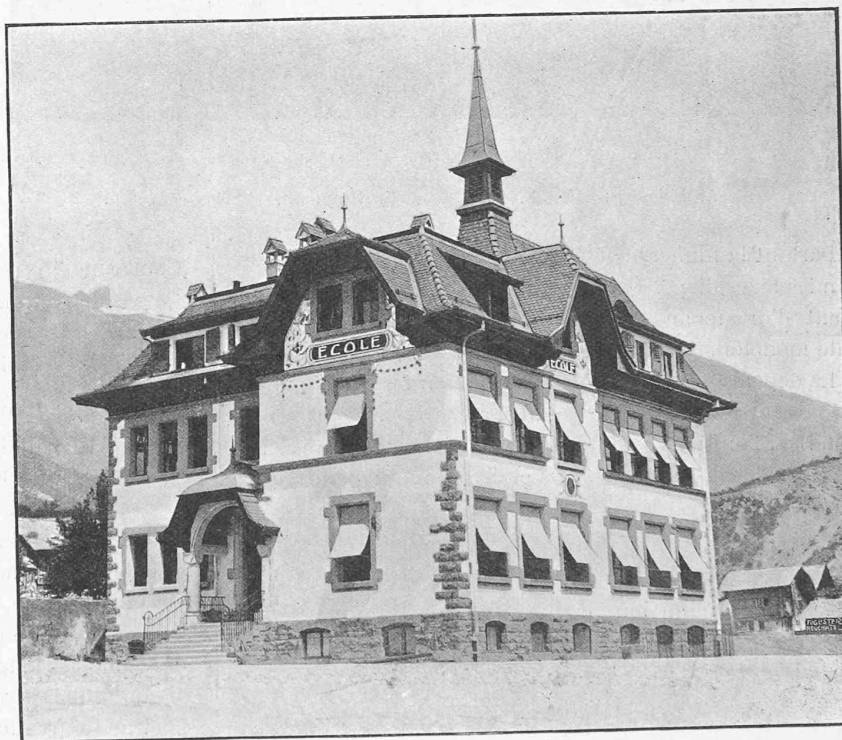
La nouvelle école de Sierre — Façades ouest et sud.
