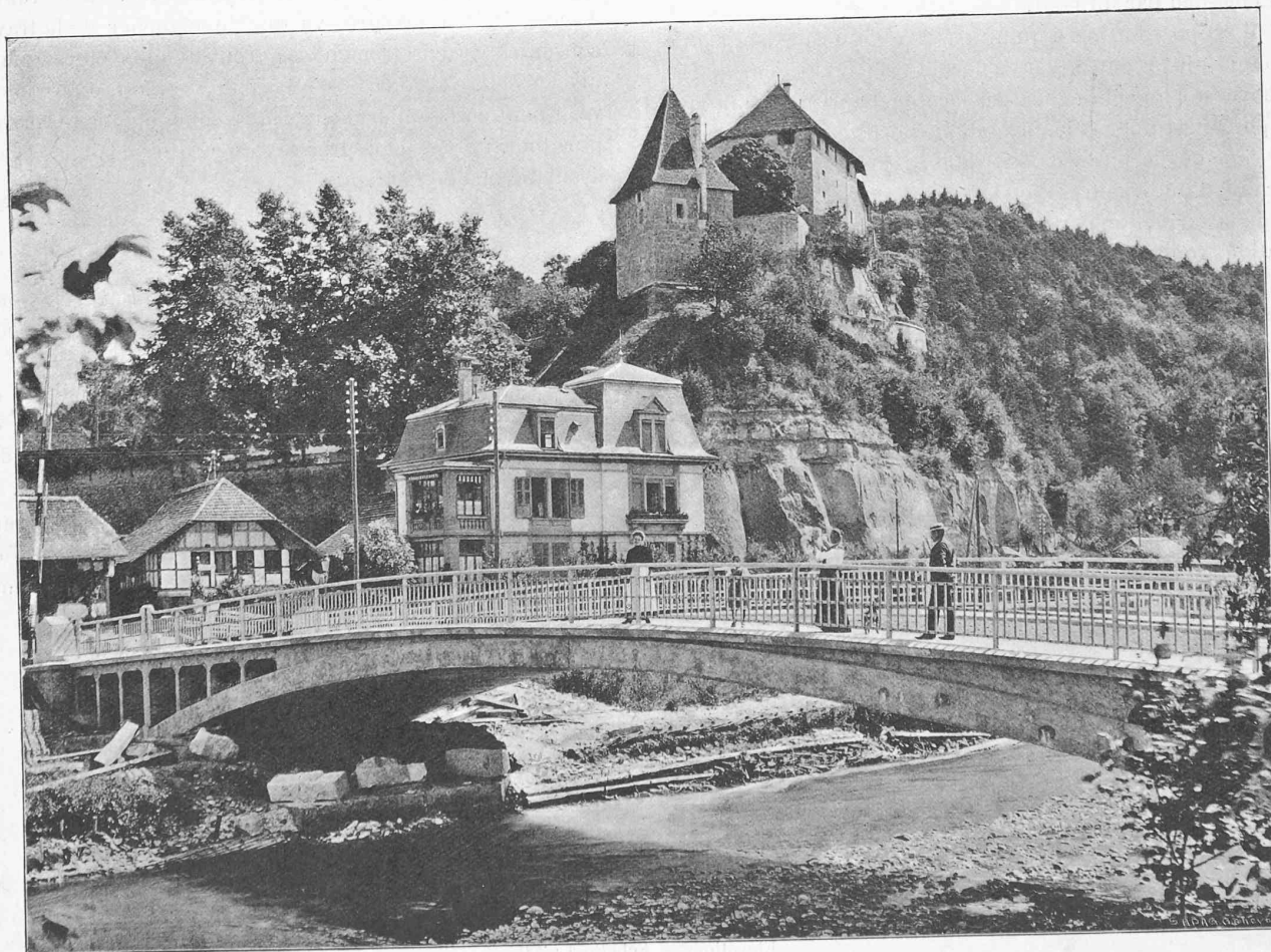
Fig. 1. — Le nouveau pont en béton armé, sur la Singine, à Laupen.
