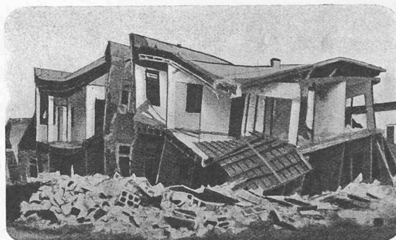
Fig. 1. — Brisure des constructions en bois, ce qui montre l'insuffisance de liaison entre les diverses parties de la construction.
