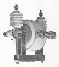
Fig. 41. — Type de transformateur de courant.
