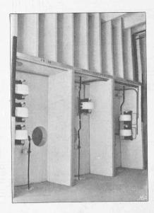
Fig. 39. — Transformateurs de courant sur le circuit des machines.
