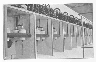
Fig. 46. - Interrupteurs automatiques des lignes.
