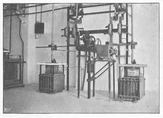
Fig. 42. — Tableau des excitatrices avec régulateur automatique Thury.
