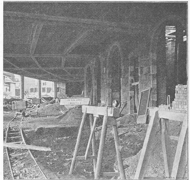
Le nouveau fleximètre Borgeaud pendant les essais de la terrasse en béton armé de la gare de Montreux.
