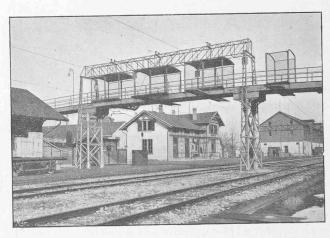
Fig. 41. — Station de Seebach. — Passerelle et suspension caténaire simple. — Prise de courant par dessous.
