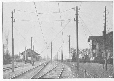
Fig. 45. — Station d'Affoltern. — Suspension par pièces en L couché.
