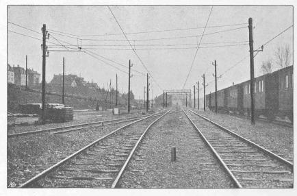
Fig. 43. — Station de Seebach. — Suspension par boucles. Prise de courant par dessous.
