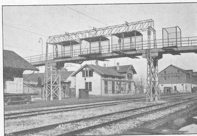
Fig. 11. — Station de Seebach. — Passerelle et suspension caténaire simple. — Prise de courant par dessous.
