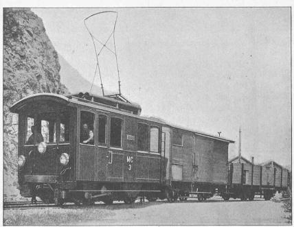
Fig. 47. — Locomotive électrique remorquant un train de marchandises.
