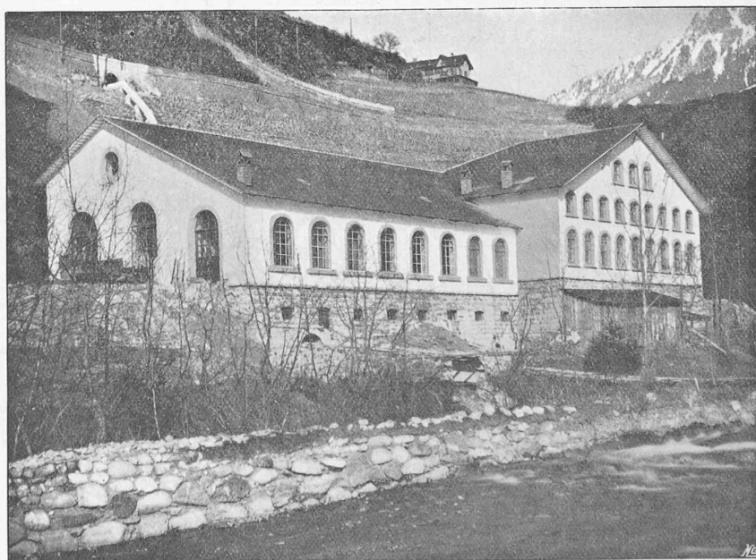
Fig. 6. — Ensemble de l'usine des Farettes.
