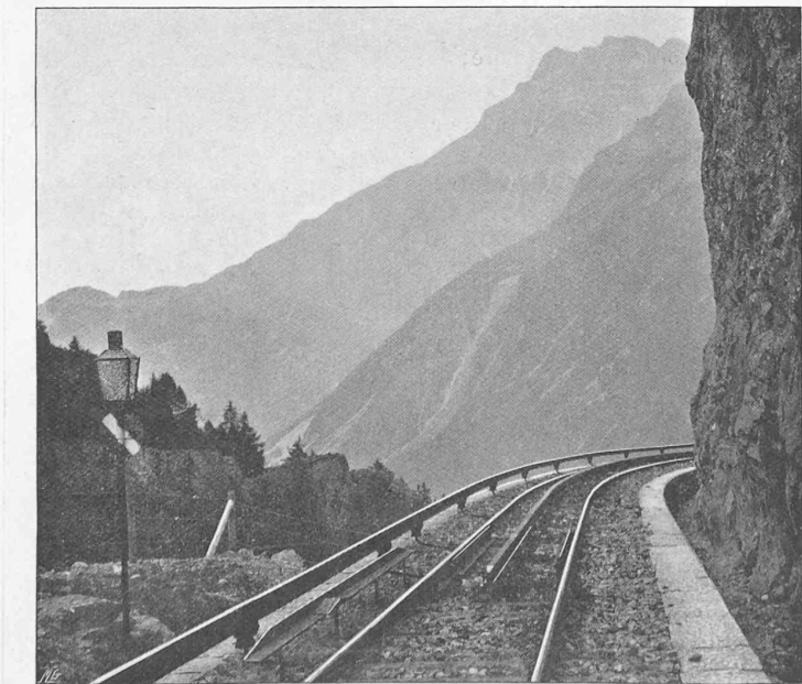
Fig. 32. — Extrémité supérieure du tronçon à crémaillère.
