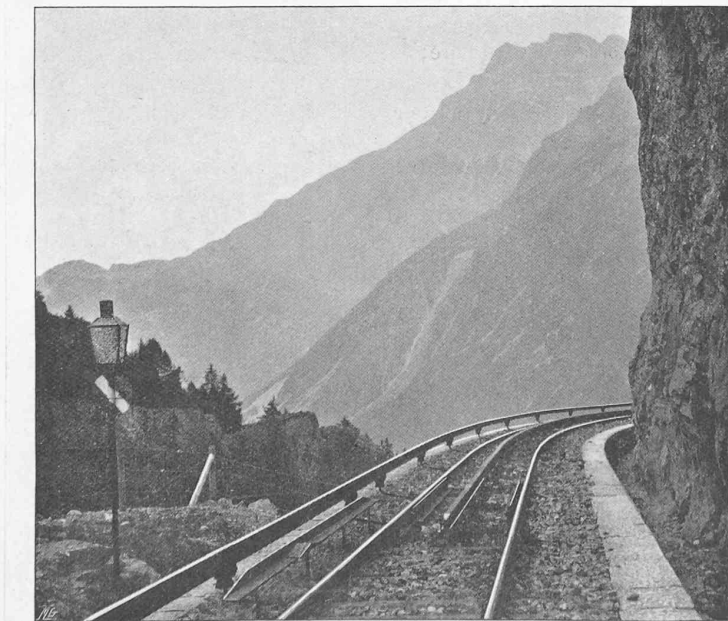
Fig. 32. — Extrémité supérieure du tronçon à crémaillère.
