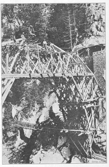
Fig. 14. — Cintre du viaduc du Triège.
