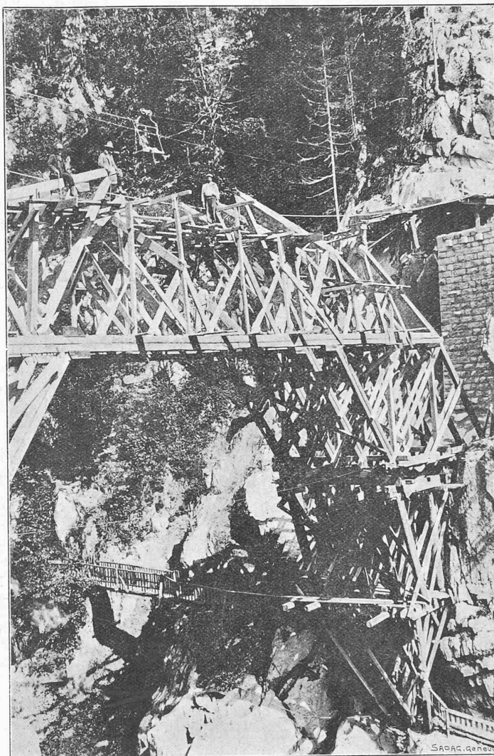
Fig. 14. — Cintre du viaduc du Triège.
