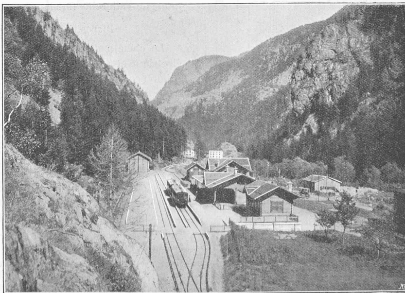
Fig. 4. — Vue de la gare du Châtelard.
