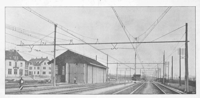
Fig. 24. \_\_\_ Station de Wettingen. \_\_ Pont-support pour 6 lignes à suspension caténaire.
