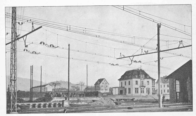
Fig. 28. — Station de Wettingen. — Section isolée à l'entrée de la remise.
