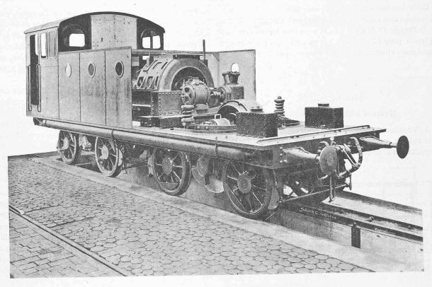
Fig. 30. — Vue intérieure de la locomotive transformatrice de 500 HP.
