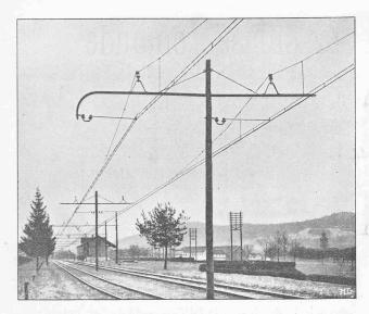
Fig. 22. — Double ligne à suspension caténaire sur poteau en bois imprégné.
