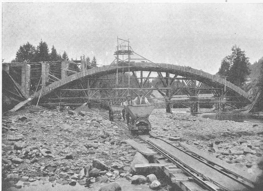
Fig. 7. — Nouveau pont de Guggersbach. — Vue des échafaudages.
