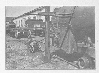
Fig. 8. — Appareil à aléser et tarauder commandé par un moteur de 3 HP, monté sur roues.
