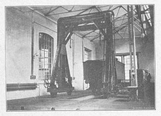
Fig. 17. — Grue électrique de levage de locomotives.
