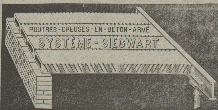
Le plus ancien et plus éprouvé des systèmes de béton armé, fabriqué machinelement
