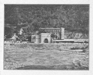
Fig. 4. — Tunnel du Simplon. — Vue du portail, côté Brigue, avec le caisson provisoire amenant l'air des ventilateurs à la galerie parallèle.
