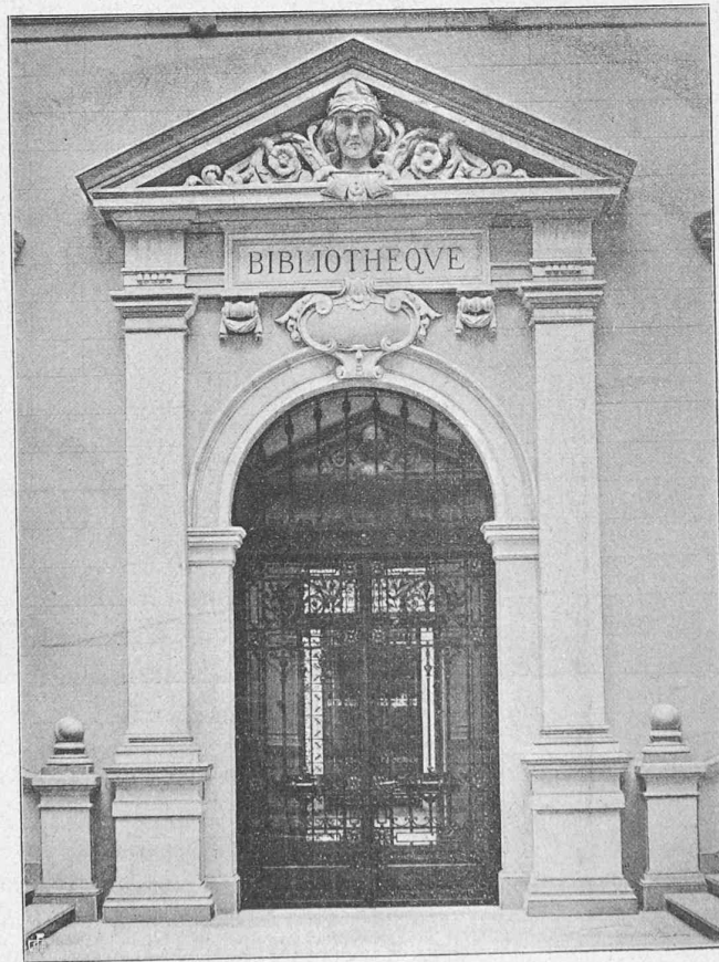
Fig. 19. — Portes latérales de l'Atrium (corps central).
