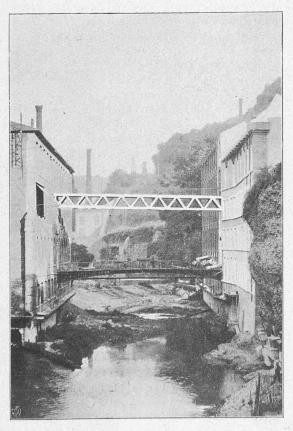
Passerelle en ciment armé de 20<sup>m</sup>,25 de portée, à l'Usine de MM. Vaganay frères, à Vienne (Isère).
