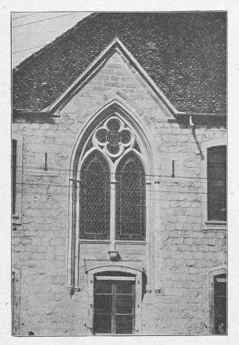
Fig. 2. — Château d'Yverdon. — Fenêtre restituée dans la face orientale. (Vue prise au « téléphot »).
