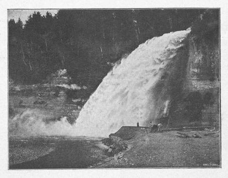
Fig. 6. — Déversoir du trop-plein du canal d'amenée.
