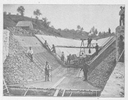
Fig. 5. — Construction du canal d'amenée en béton armé.
