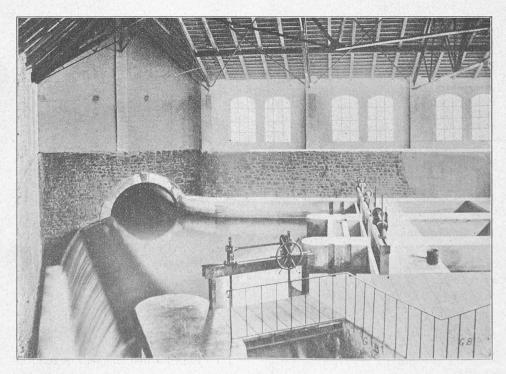
Fig. 7. — Chambre de mise en charge.
