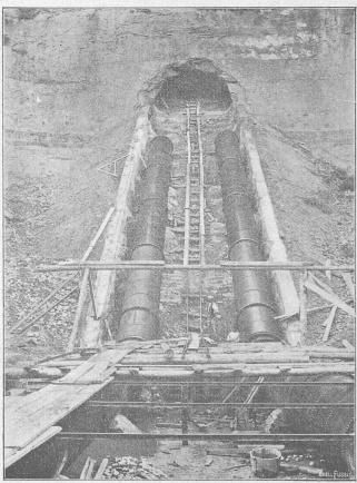
Fig. 9. - Montage des conduites forcées.
