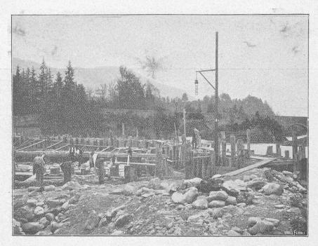
Fig. 4. — Pilotage du mur de la prise d'eau.
