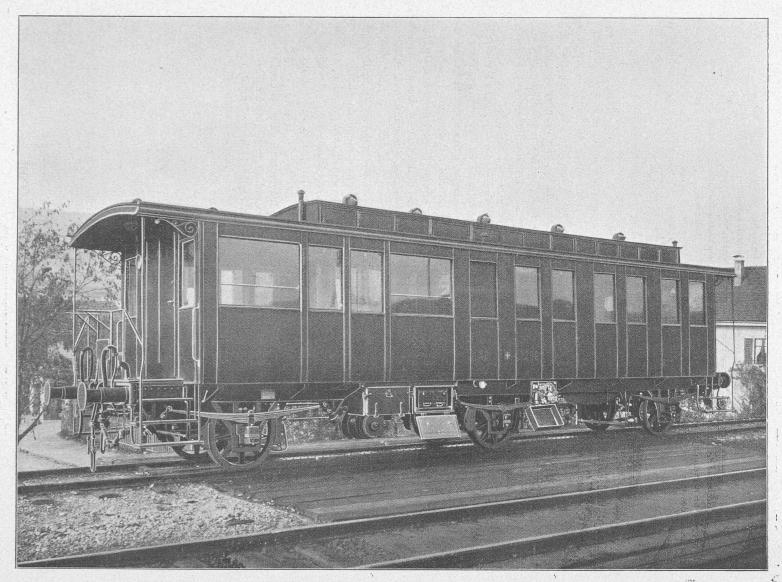
Fig. 1. — Voiture de  $I^{r_0}$  et  $II^{r_0}$  classe, avec équipement pour l'éclairage électrique, système Aichele (Appareils montés à l'extérieur, contre le châssis).
