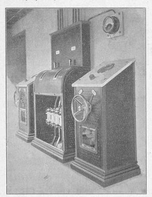
Fig. 20. — Tableaux de manœuvre pour les primaires et secondaires des transformateurs et pour les feeders à 500 volts.
